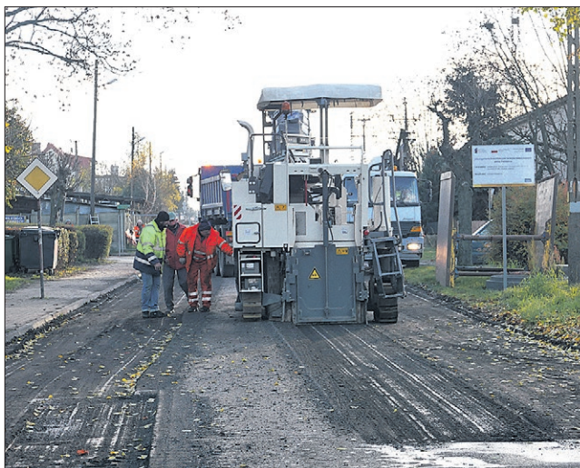
Przebudowa drogi do terenów inwestycyjnych
