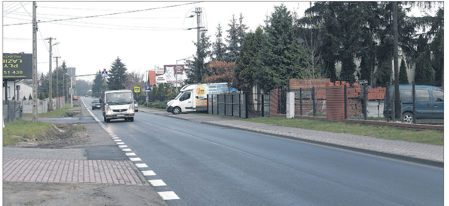
Przy okazji modernizacji sieci wodno-kanalizacyjnej odtworzono nawierzchnię asfaltową
